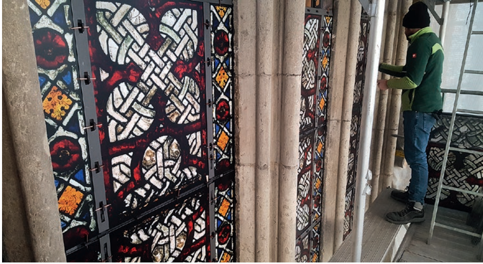
13. Einbau der Fotoimitate aus Plexiglas in Fenster N IV.
