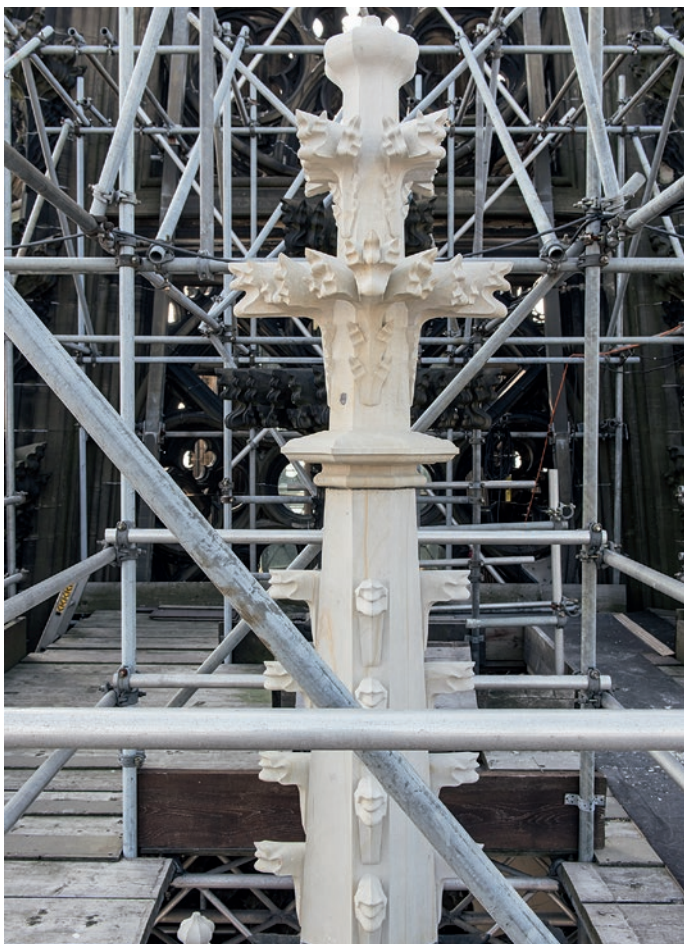
3. Neuer Fialaufbau, bestehend aus Riese und Kreuzblume, an Pfeiler F 1 des Nordturmes.
