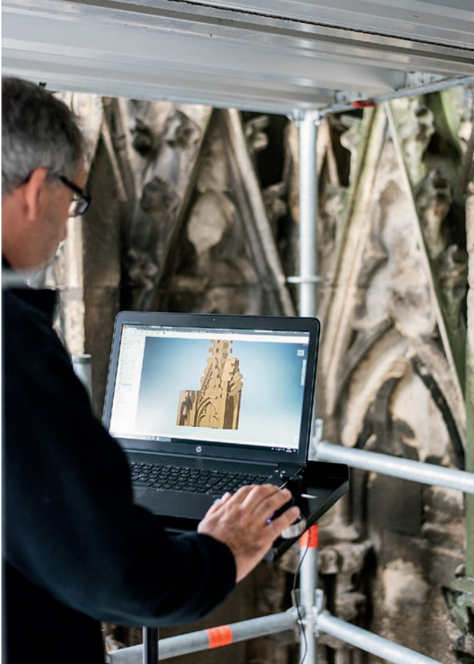
7. Aufmaß und Kontrolle der Konstruktion vor Ort.
