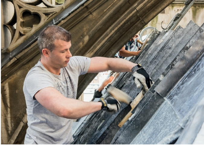
11. Erneuerung der Bleideckung des Daches über der Marienkapelle.
