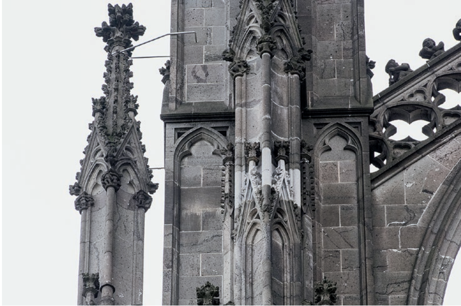
9. Wiederhergestellter Fialaufbau an Pfeiler K 11 mit neu gefertigtem Werkstein.
