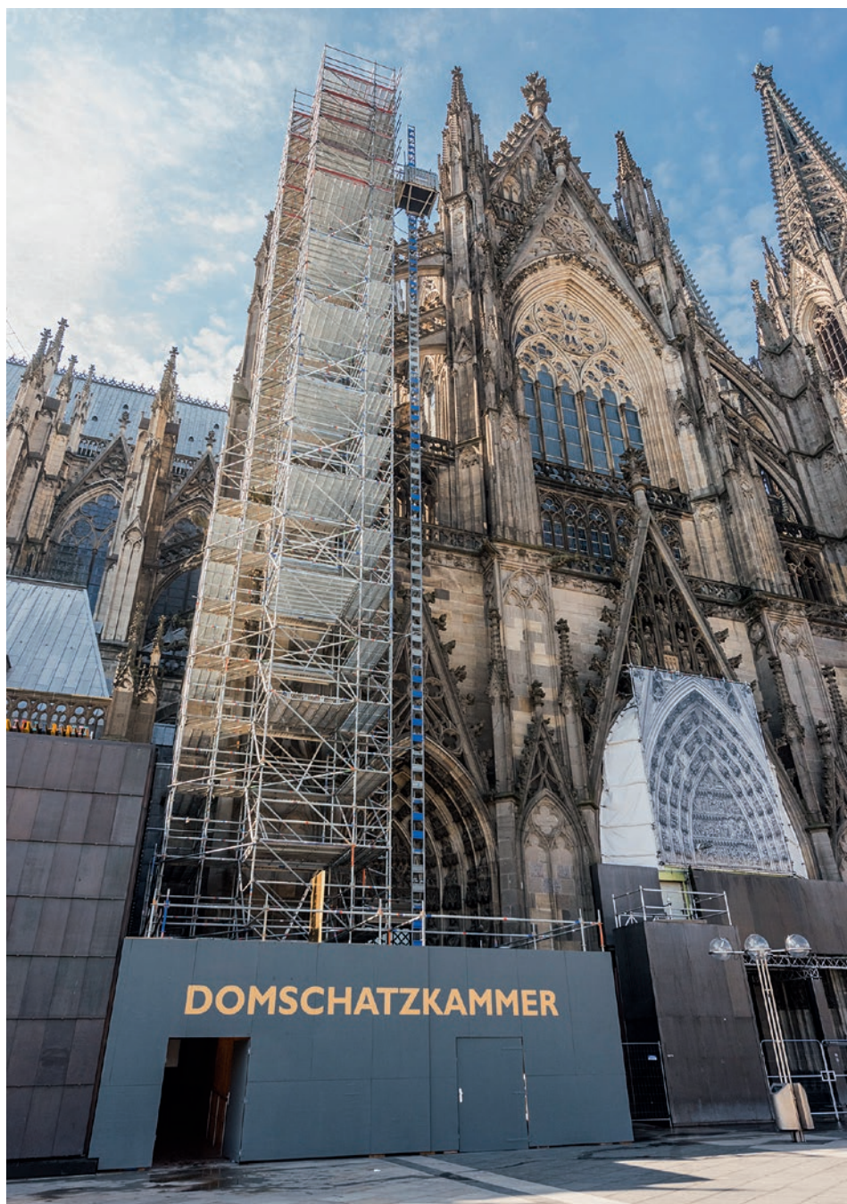
2. Eingerüsteter Pfeiler K 11 an der Nordquerhausfassade.
