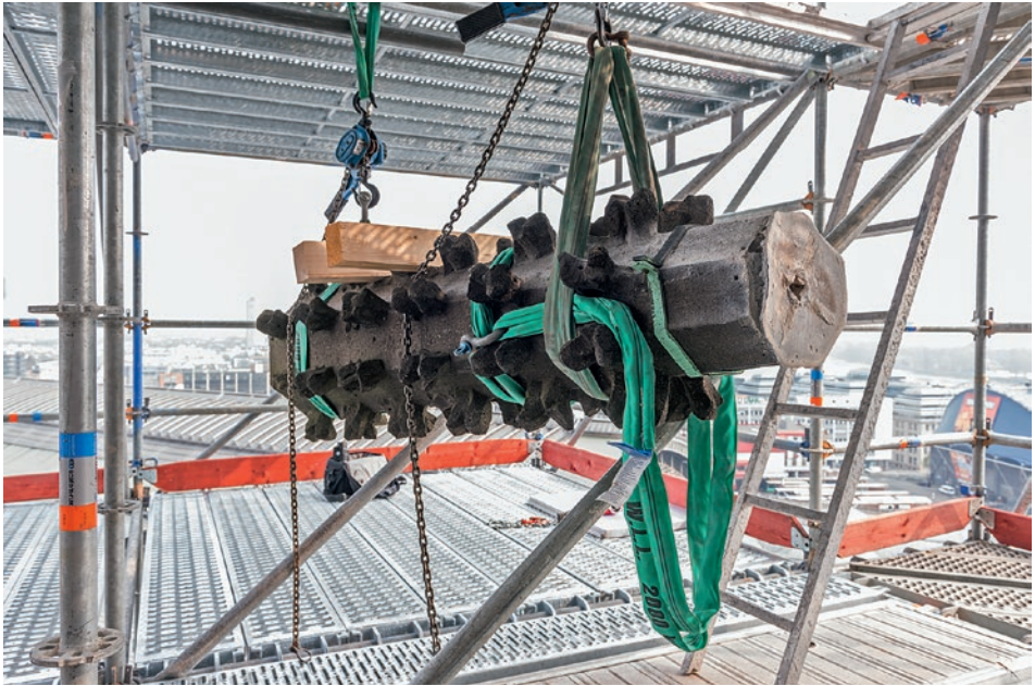
8. Abtransport eines abgebauten Riesen von Pfeiler K 11.
