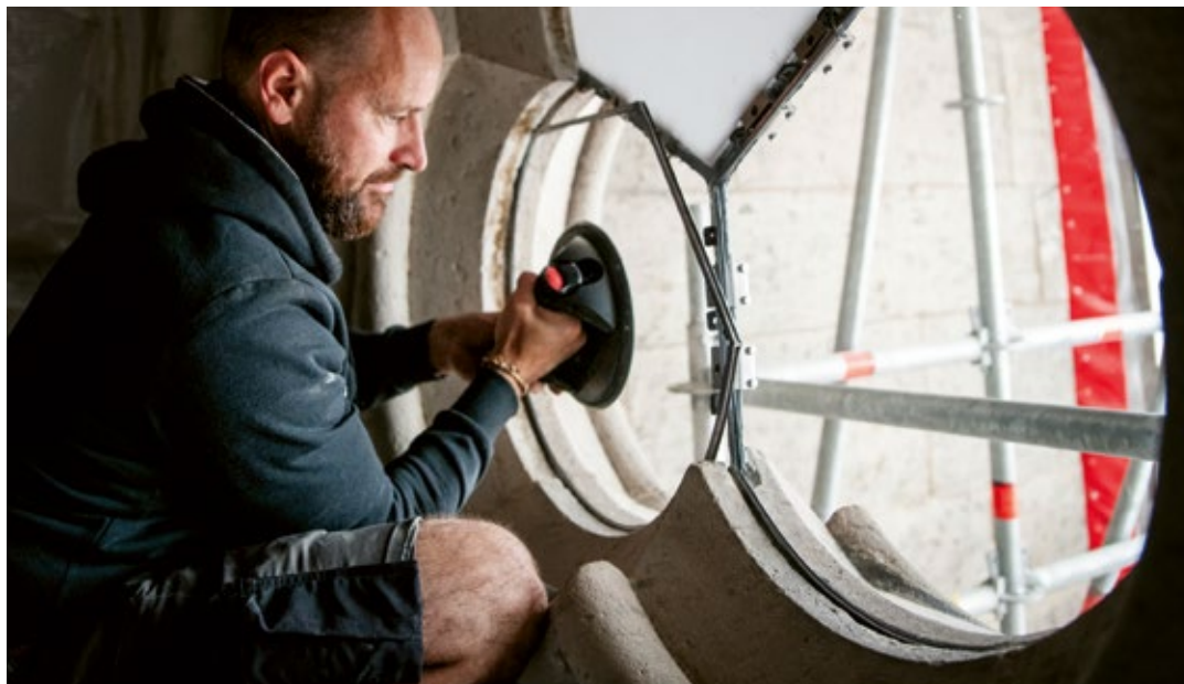
20 | Montage der Schutzverglasung im Maßwerk der Engelbertuskapelle
