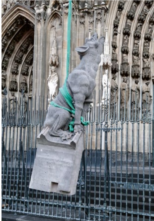
11 | Der neue Wasserspeier an Pfeiler G 11 wird versetzt.
