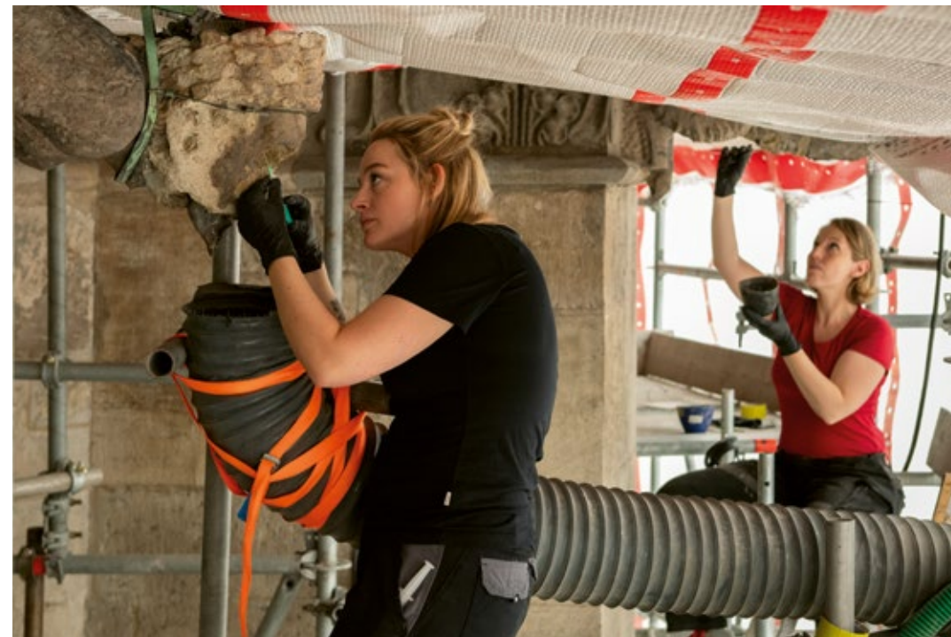
14 | Restaurierung der mittelalterlichen Wasserspeier am Chorkapellenkranz
