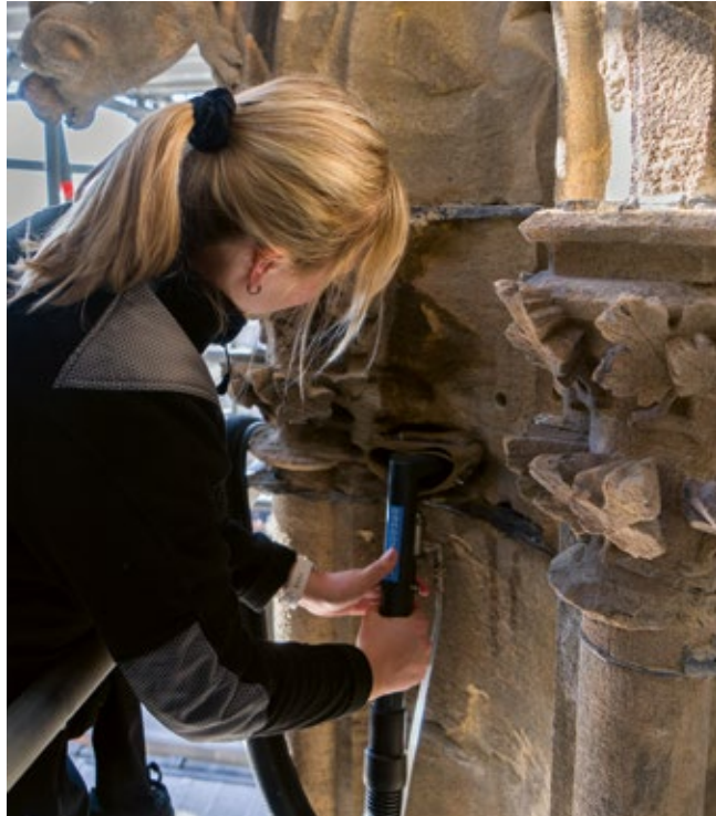
7 | Lösung und Absaugung der Salze unter Verwendung eines Vakuum-Spülsaugers
