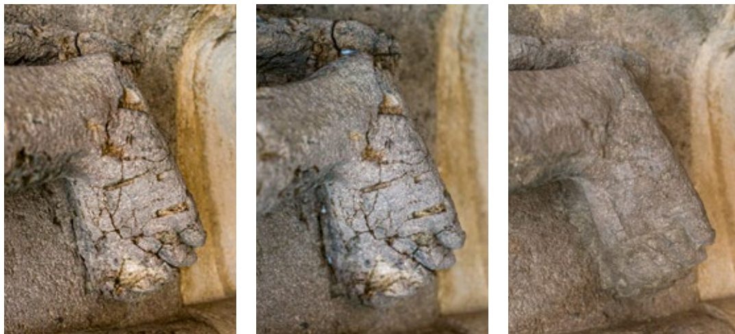
15 | Fuß des Wasserspeiers in Form eines Hockenden an Pfeiler F 15 im Vorzustand, nach der Klebung und mit Mörtelergänzungen
