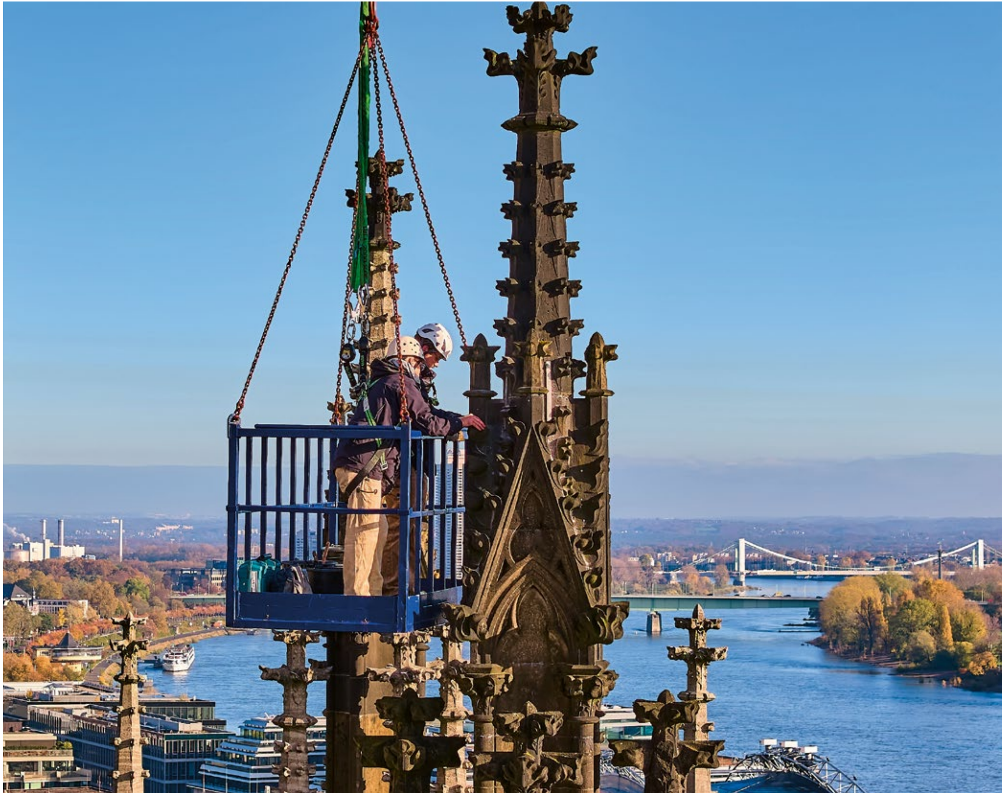
2 | Vom Mannkorb aus wurde der Fialaufbau durch vier Edelstahlsteifen stabilisiert.
