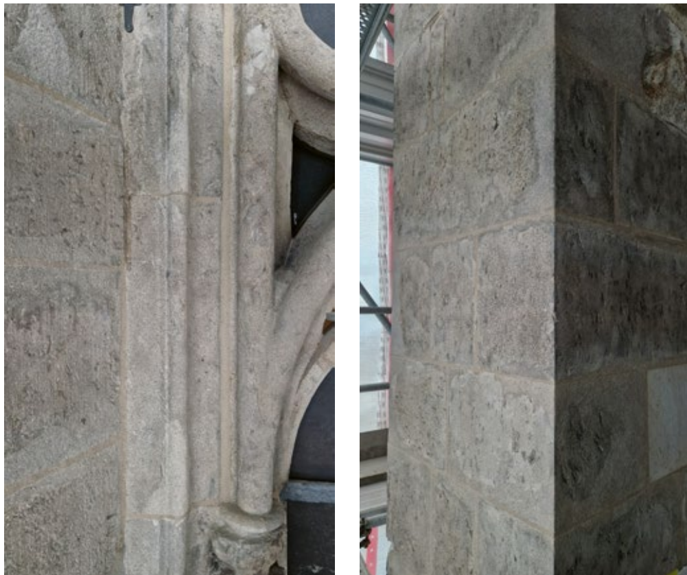
15 a–b | Fenstergewände und Strebepfeiler nach der Restaurierung des mittelalterlichen Trachytmauerwerks
