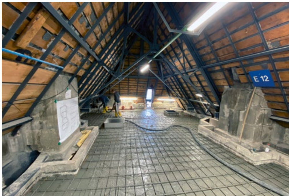
16 | Betonieren der neuen Decke über Feld 045 und 046
