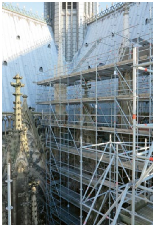
11 | Wiederhergestellte Fialaufbauten B 09 und C 09 an der Dachgalerie vor dem Abbau der Gerüste
