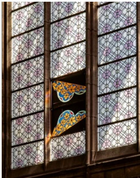
17 | Provisorischer Einbau von zwei Maßwerkteilen zur Prüfung der Farbwirkung zweier unterschiedlicher Blautöne
