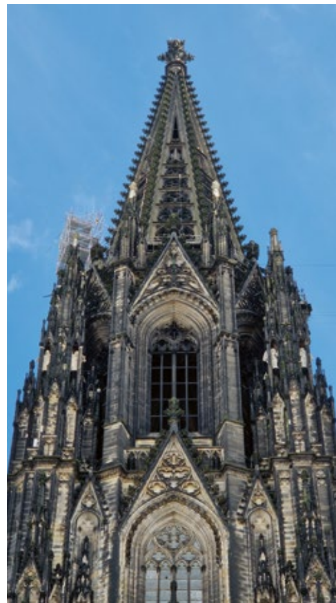
6 | Nach der Wiederherstellung der Fialaufbauten am Helmansatz ist die Silhouette des Nordturmes nach etwa achtzig Jahren wieder vervollständigt.
