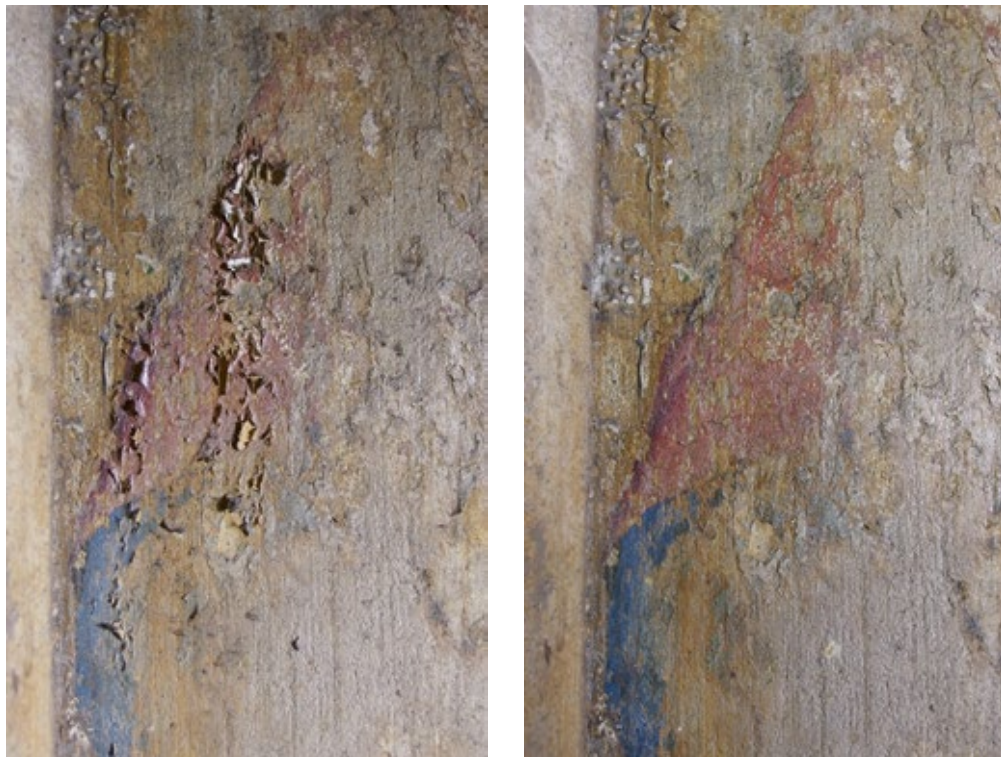
21 a–b | Chorschranke Süd I, Außenseite, Bereich eines Gewandes vor und nach der Restaurierung
