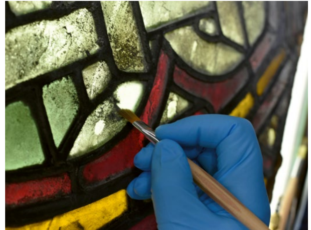
19 | Die vorsichtige Entfernung von Schmutzauflagerungen und Korrosionsschichten führt zu deutlich mehr Transparenz und Farbigkeit der mittelalterlichen Gläser.
