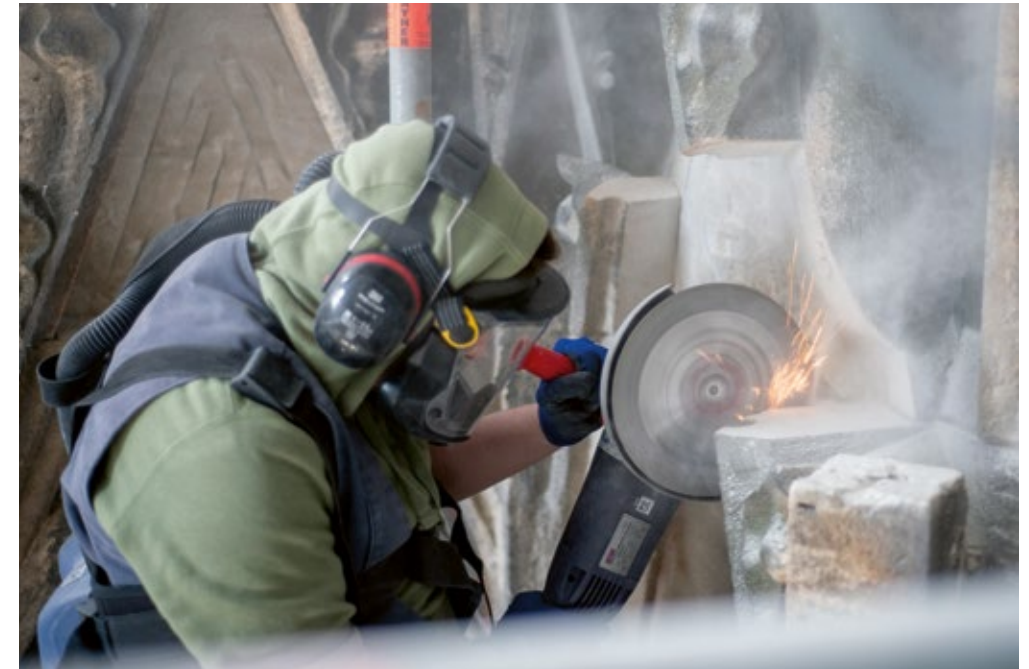
8 | Ausbau für Vierungen an der Strebepfeilerbasis A 08
