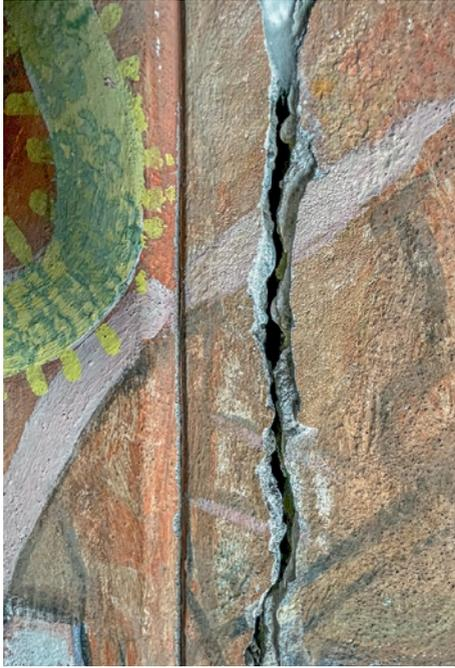
20. Materialausbrüche an den Kanten eines Risses, der mehrere Bildmotive der Malereien unter der Orgelempore durchzog
