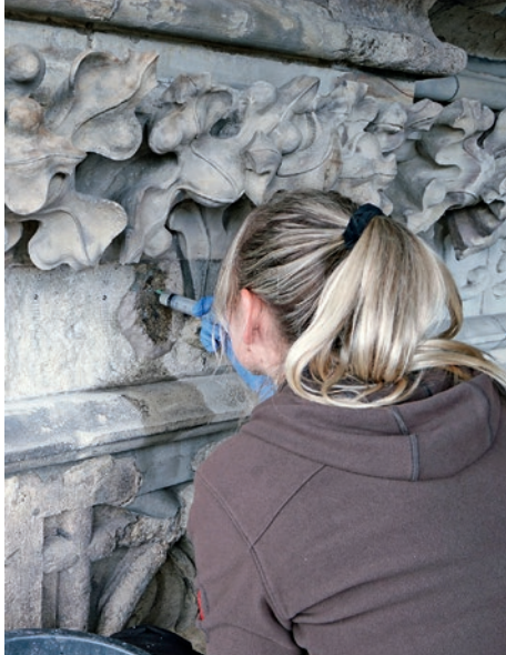
9. Rissinjektion an einem mittelalterlichen Blattwerkfries aus Drachenfels-Trachyt
