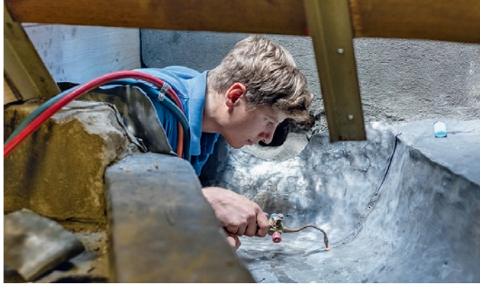
19. Reparatur einer Wasserrinne im Bereich der Chorkapellendächer
