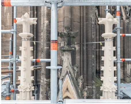
13. Erneuerte Fialen am östlichen Pfeiler der Südquerhausfassade G 11
