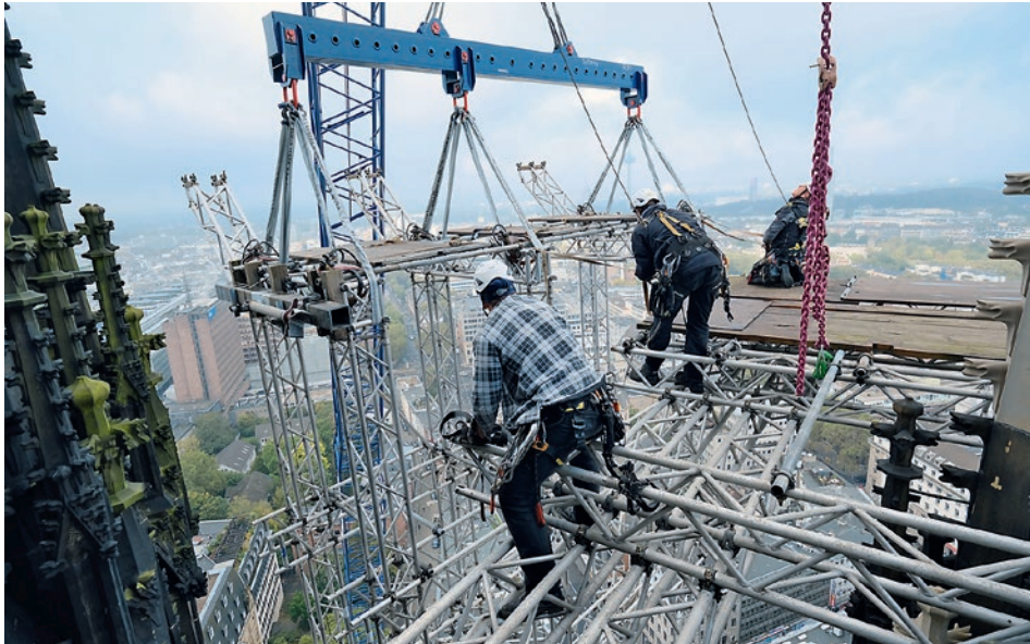
2. Abbau des Hängegerüsts an der Nordwestecke des Nordturmes
