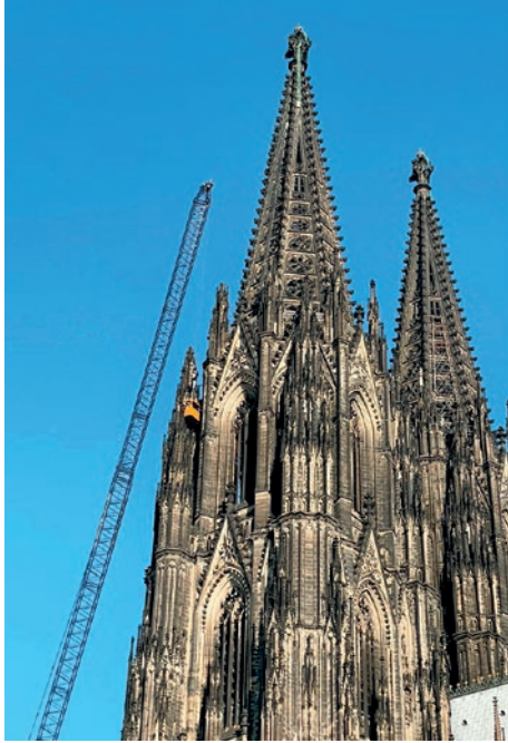
3. Bauwerksmonitoring durch Befahrung der Westfassade mit einem Fahrkorb am Kran
