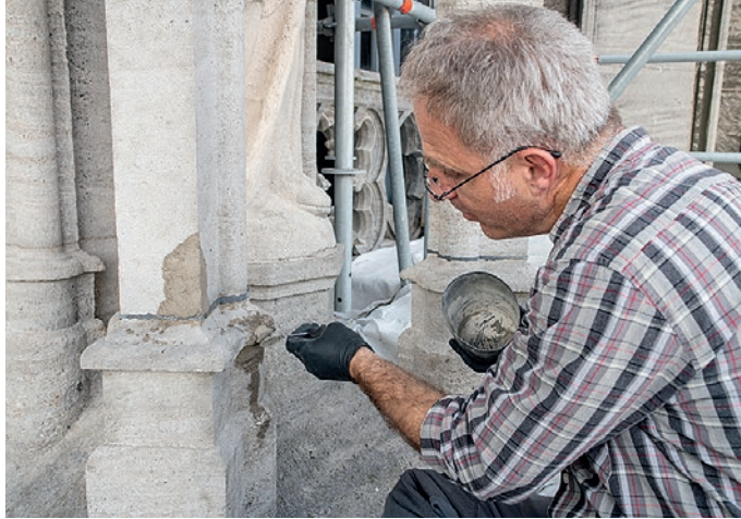
10. Ergänzung von Fehlstellen mit Antragsmörtel an einem Figurentabernakel am Chor
