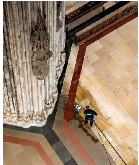
31. Grundreinigung der Steinböden in Lang- und Querhaus
