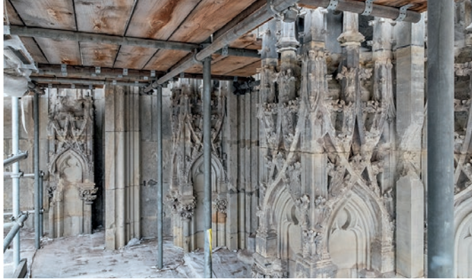
12. Maßwerk an Pfeiler F 3 während der Reinigung
