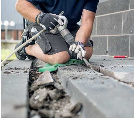
17. Ausstemmen schadhafter Fugen an Domsockel und Rinne
