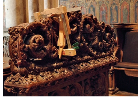
35. Rissverklebung an einer Chorgestühlswange
