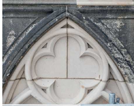
14. Erneueres Blendmaßwerk am östlichen Pfeiler des Südquerhauses
