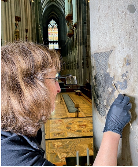
32. Festigung der Wandmalereifragmente an Chorpfeiler C 18
