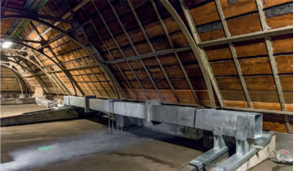
13. Stahlträger zur Entlastung der Kappendecken über dem östlichen Seitenschiff des nördlichen Querhauses.
