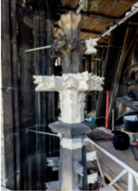
4. Fialaufbau mit Vierungen an Nordturmpfeiler F 1.
