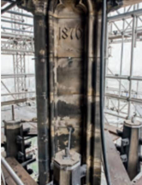
12. Neue Edelstahldübel und Anker für die Arbeiten an Nordturm Pfeiler F 1.
