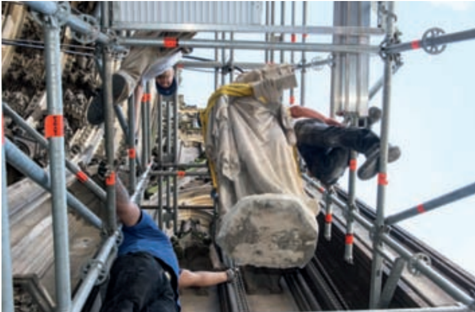
5. Versetzarbeiten am Dreikönigenportal.
