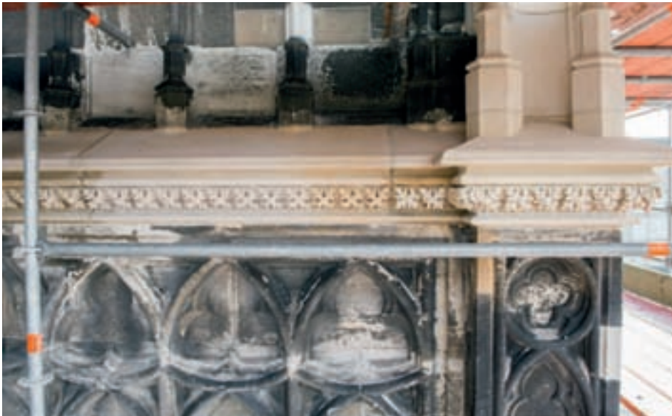
3. Erneuerter Blattfries an Pfeiler G 8.
