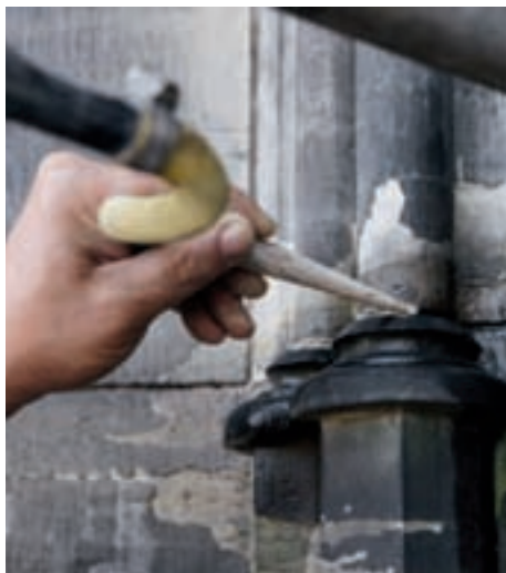
10. und 11. Erneuerung der Fugen am Nordturm.
