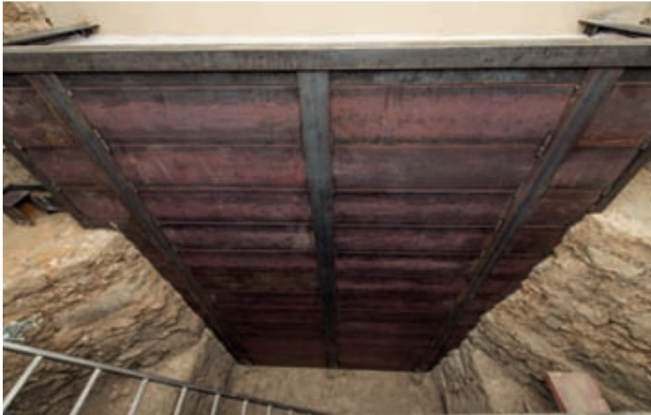
26. Spundwand zur Sicherung des Erdreiches unterhalb des Fußbodenfeldes 33/34.
