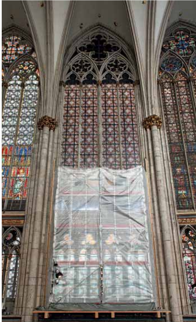
18. Ersatzverglasung im Königsfenster N V mit beidseitig laminierten Fotoimitaten, Durchlicht.
