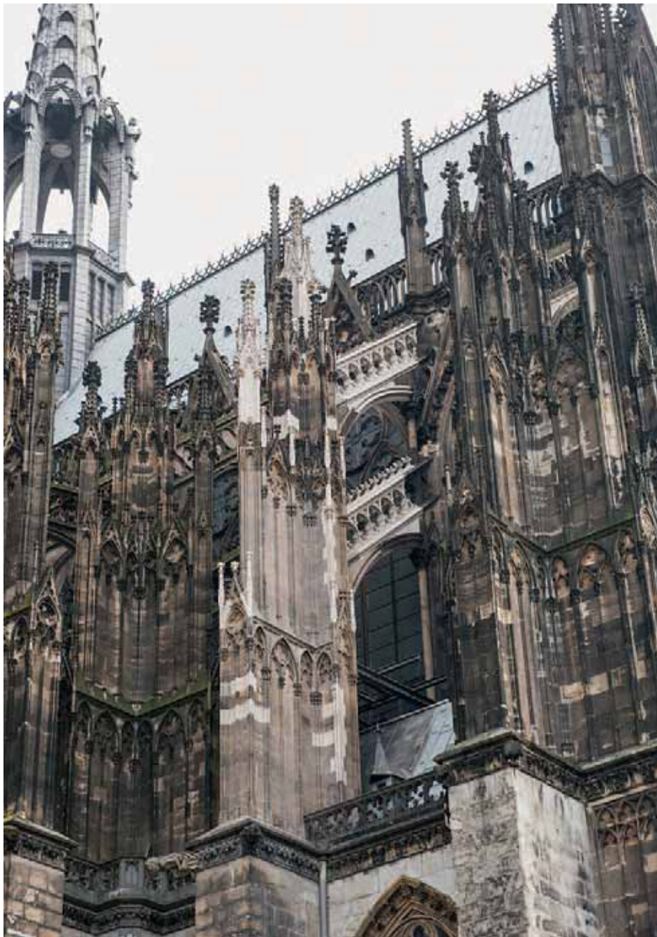
3. Strebe Pfeiler F 5 nach Abbau des Gerüsts.
