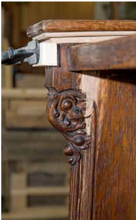
16. Bank der Sakramentskapelle während der Ergänzung in der Schreinerwerkstatt.
