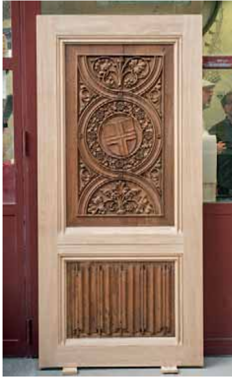
14. Aufgedoppelte Verbindungstür zwischen Sakristei und Sakramentskapelle, Zwischenzustand.
