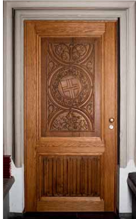
15. Aufgedoppelte Verbindungstür zwischen Sakristei und Sakramentskapelle, Endzustand.
