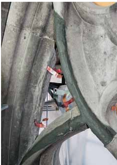
11. Steiner Ergänzung am Maßwerk des Mirjamfensters.
