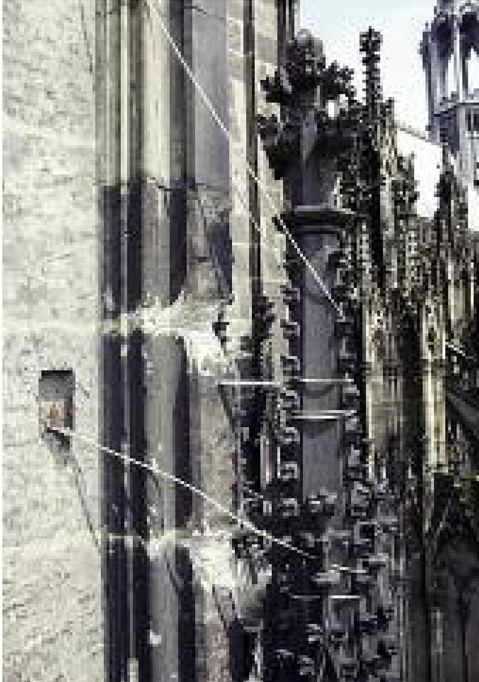
19. Mit Stahlseilen gesicherte Fiale am Südturm.
