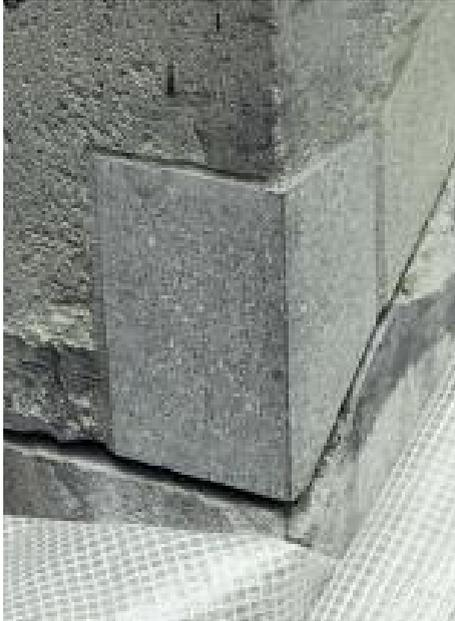
38. Vierung aus Montemerlo-Trachyt mit einer Bearbeitung nach mittelalterlichem Vorbild.
