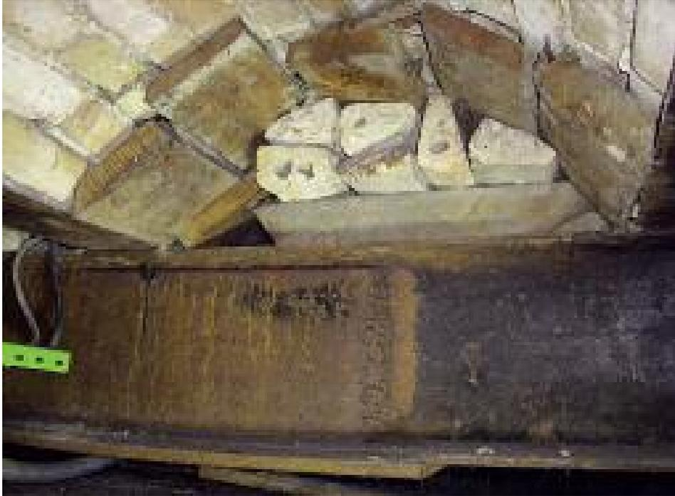
26. Korrodiertes Eisenträger der preußischen Kappengewölbedecken mit losen Ziegelsteinen über Feld 46.
