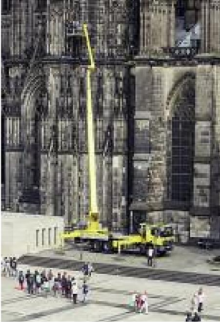
**30.** Sicherungsarbeiten mit einem Hubsteiger am Südturm.
