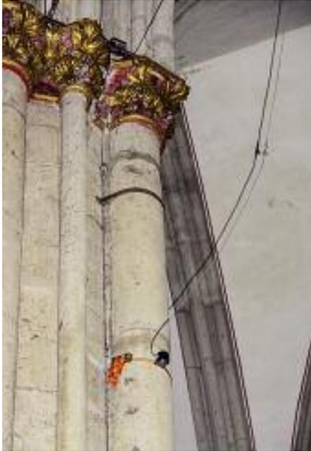
25. Erschütterungsmessgerät an einem Chorpfeiler.
