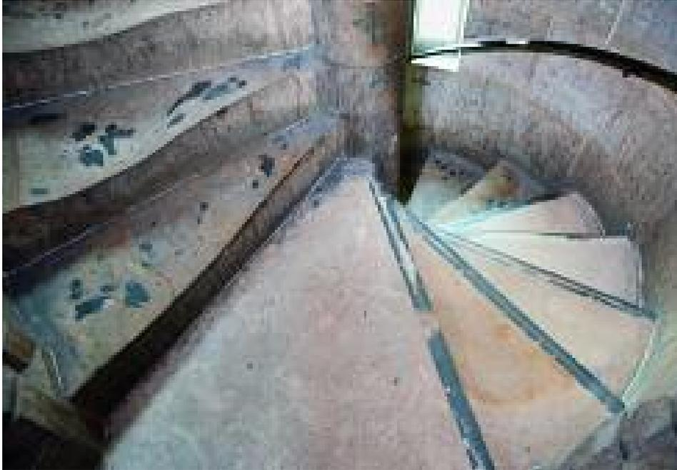
32. Probeweise mit Romanzement reparierte Treppenstufen im Südturmaufgang.
