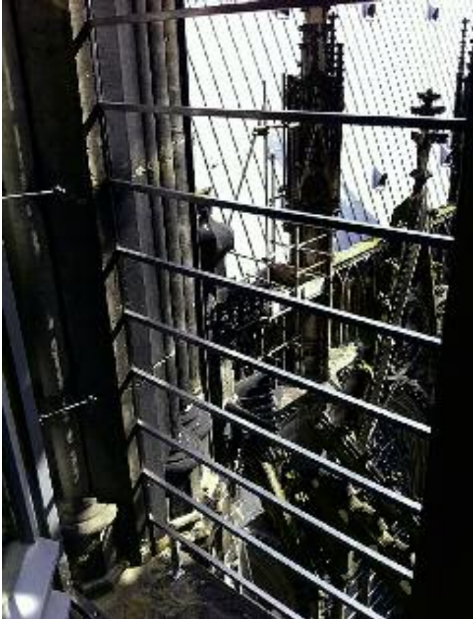
9. Absturzsicherung vor den Fenstern im Glockenstuhl des Südturmes.
