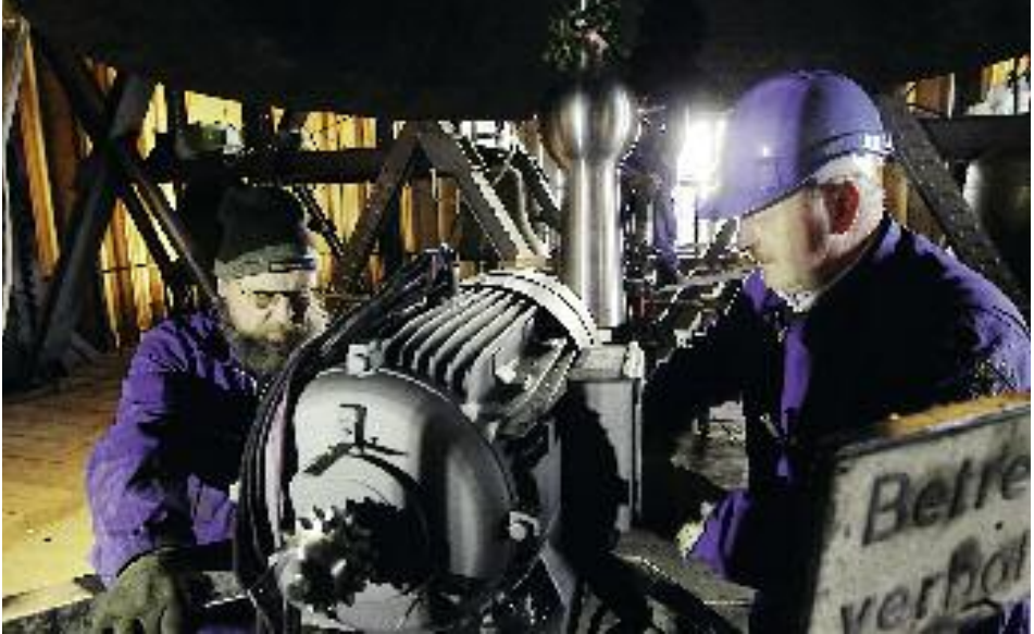
13. Arbeiten am neuen Antriebsmotor der Petersglocke.
