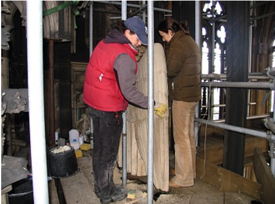
10. Auftragen der festigenden Schutzschlämme an einem der Engel des Nordturms.
