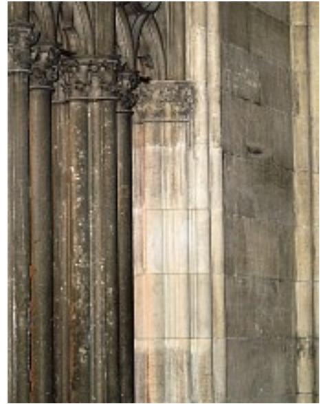
8. Westliches Gewände des Südquerhausfensters nach der Instandsetzung.
