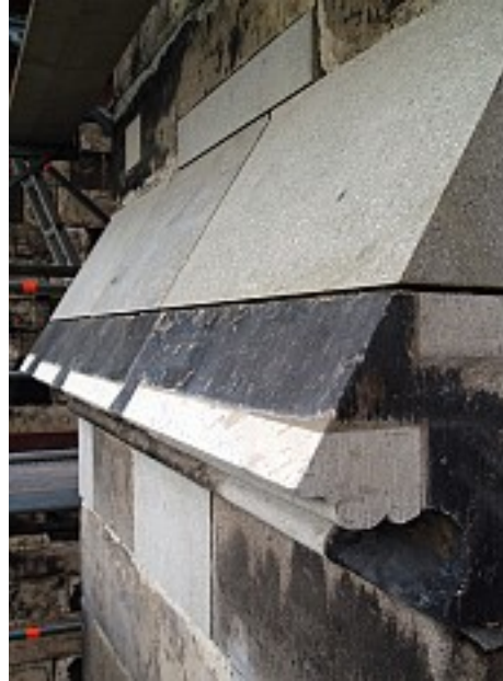
3. In Teilen erneuerter mittelalterlicher Wasserschlag am Strebepfeiler F 6.
