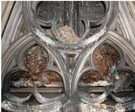
16. Maßwerk eines Couronnements vor der Reinigung und vor dem Einsetzen eines Taubenschutznetzes.
