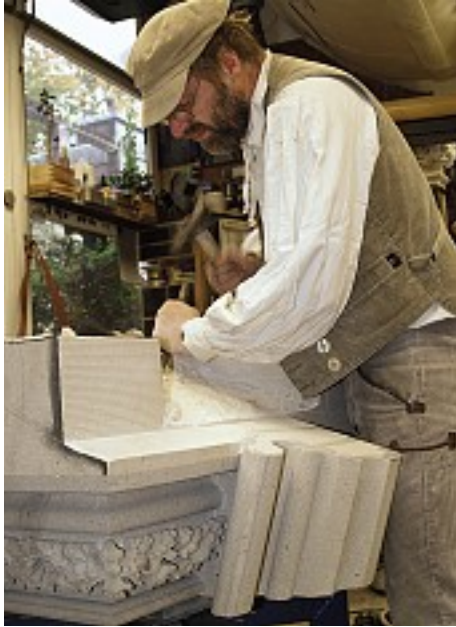
5. Steinmetz Markus Schroer bei der Arbeit an einem Profilstück mit Laubfries für einen Pfeiler der Südquerhausfassade.
