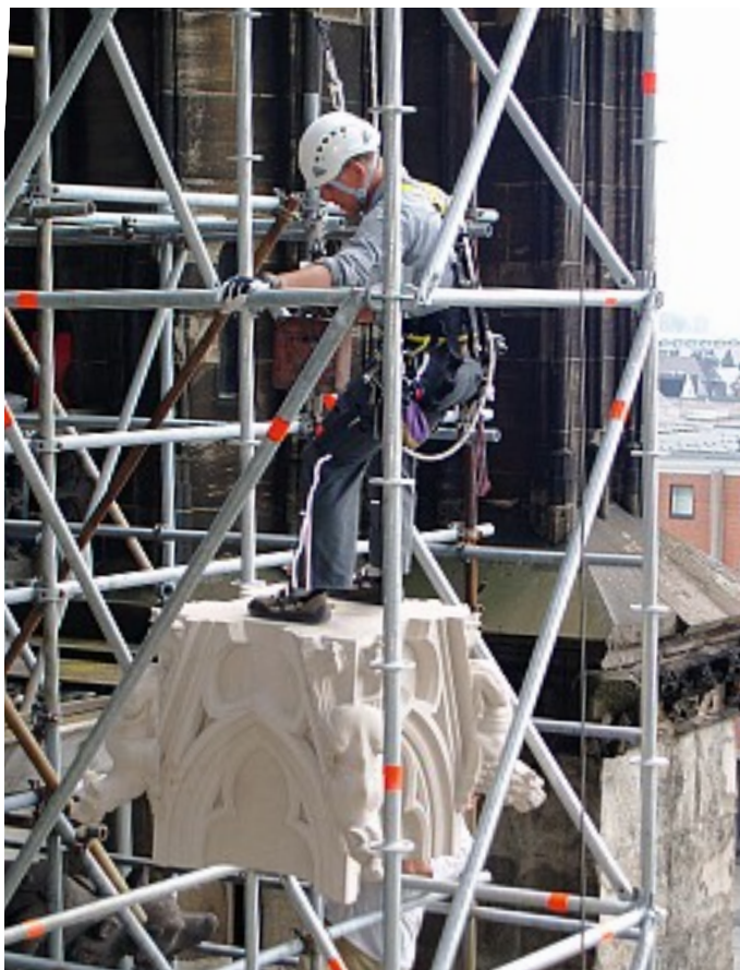
4. Hochziehen eines Fialaufbaus am Strebewerk H 8–H 9 unter Aufsicht von Gerüstbauer Wolfgang Schmitz.
