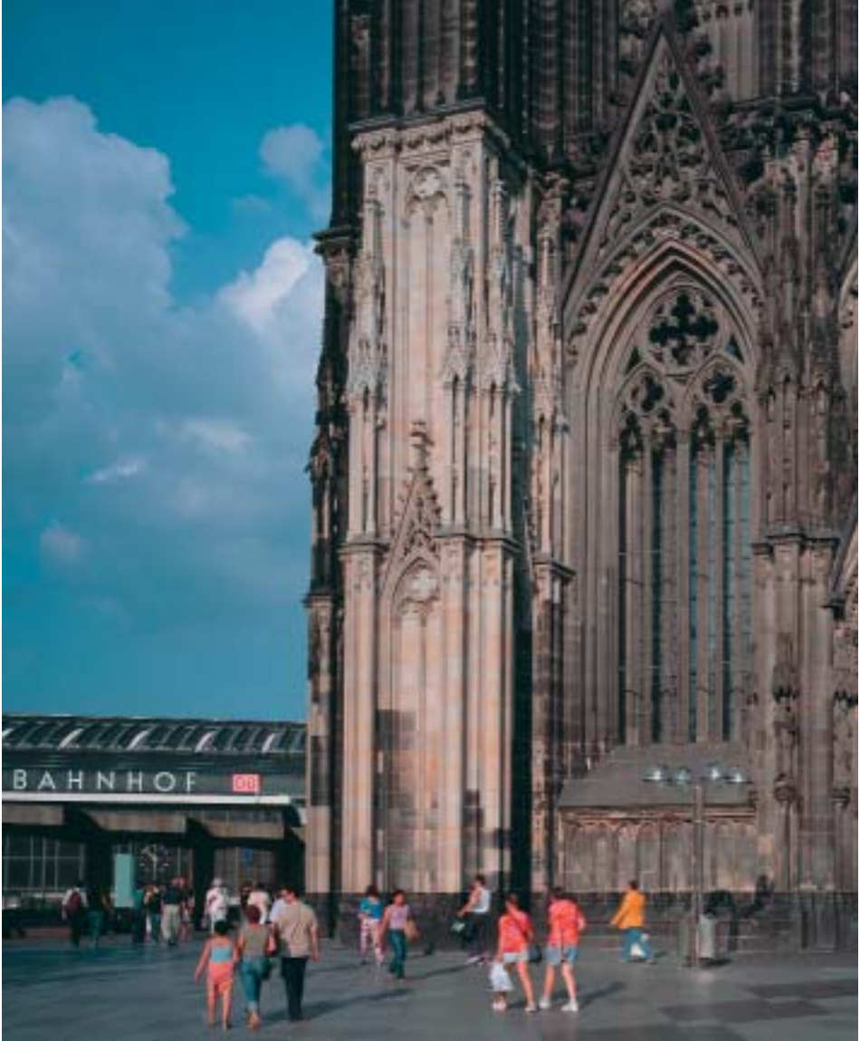
5. Die Neuverblendung der ehemaligen Ziegelplombe am Strebpfeiler F 1 des Nordturmes.
