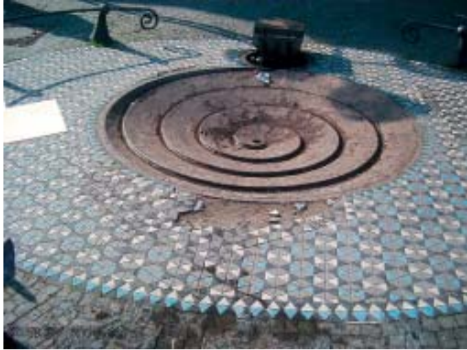
14. Beschädigter Fliesenbelag des Taubenbrunnens von Ewald Mataré vor der Westfassade des Domes.
