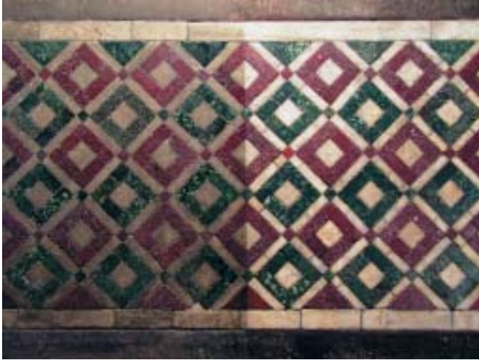
23. Deckplatte des Gerograves in der Stephanuskapelle des Domes während der Reinigung.
