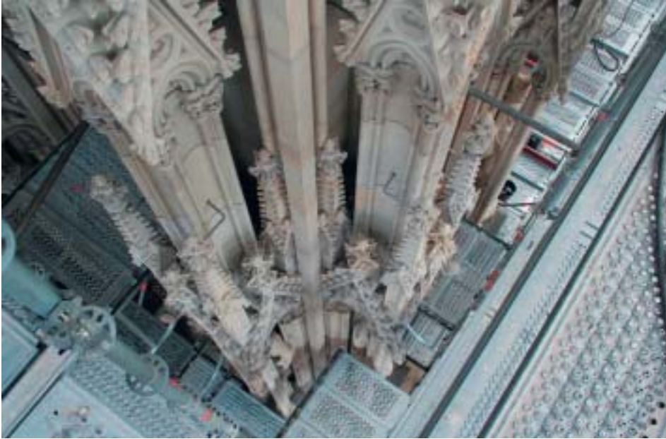
4. Neuversetzte Fialen und Kapitelle am Strebepfeiler F 1 des Nordturmes.
