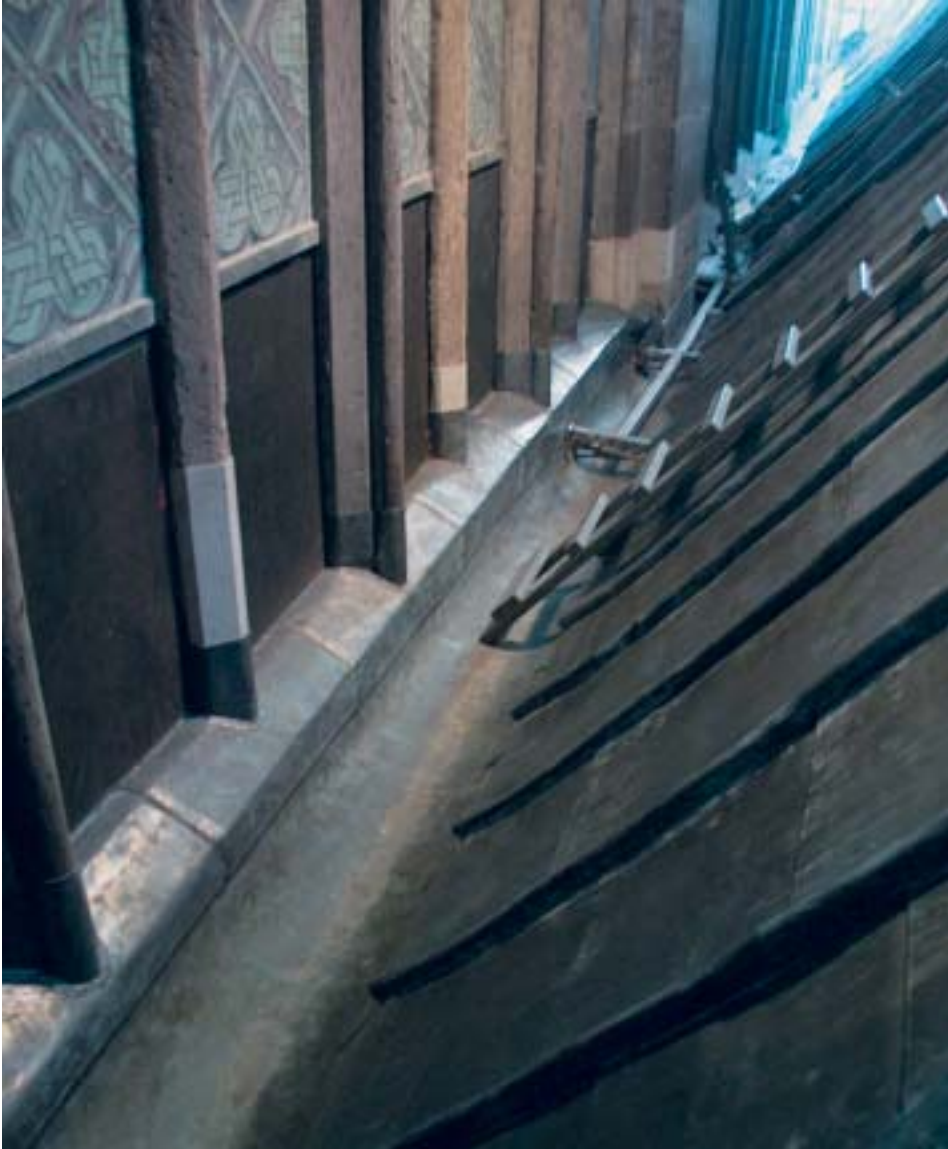
9. Verbleiungsarbeiten an der Dachrinne des Südquerhauses im Außentriforium.
