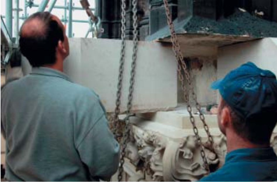
3. Versetzarbeiten am Strebepfeiler F 1 des Nordturmes.
