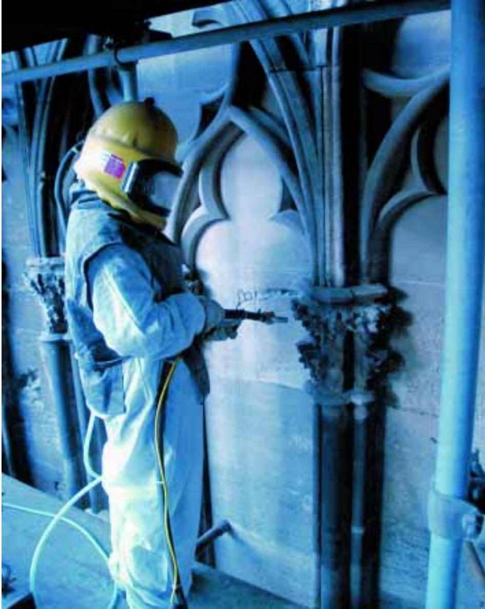
2. Abstrahlarbeiten am Strebewerk H 8–9 durch Steinmetzin Monika Müller.
