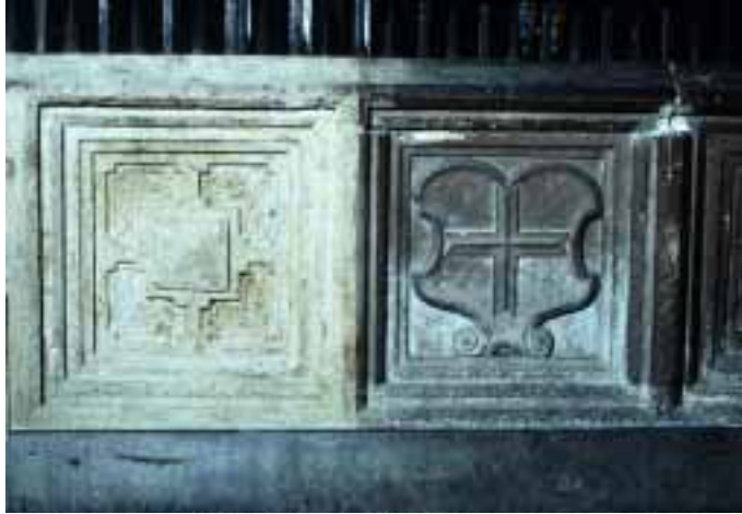
18. Steinbrüstung am Choreingang mit gereinigtem und ungereinigtem Feld.
