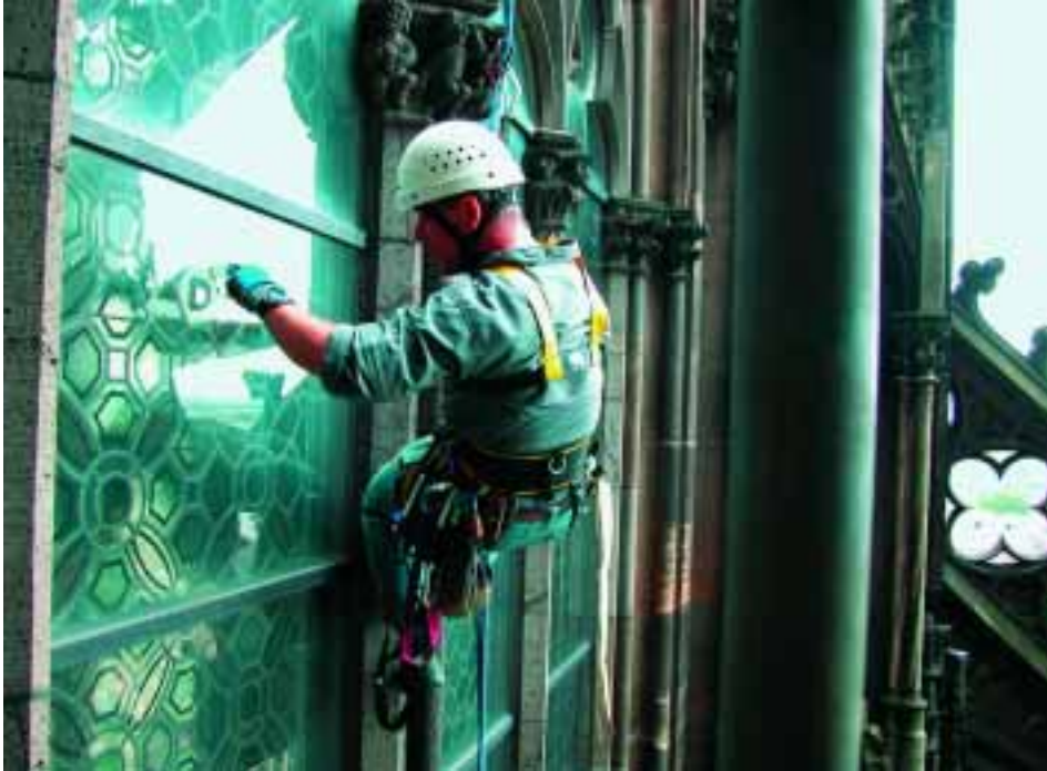
9. Montage von Glassensoren durch Gerüstbauer Wolfgang Schmitz an einem der Obergadenfenster des südlichen Querhauses.
