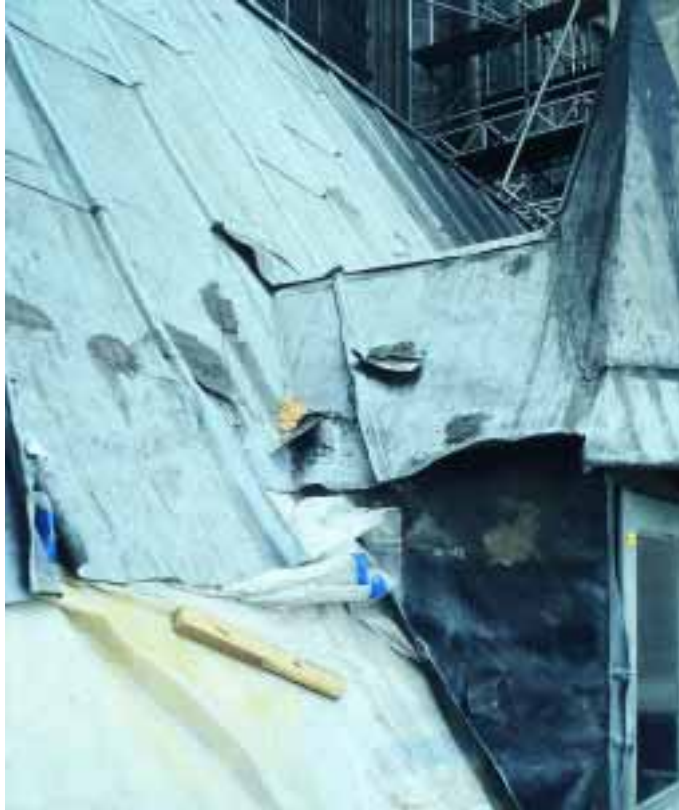
5. Erneuerung der Bleideckung am östlichen Seitenschiffdach des Südquerhauses.
