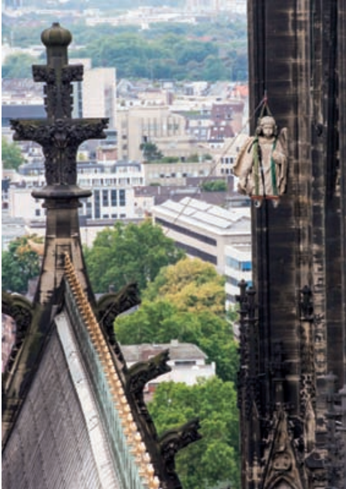
11. Ablassen des Oberteiles eines musizierenden Turmengels an der Südseite des Nordturmes.
