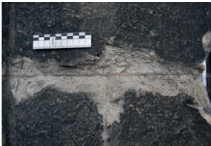
15. Detailansicht von mittelalterlichem Steinwerk und Fugenbild im Bereich des Fensters N III vor der Restaurierung.
