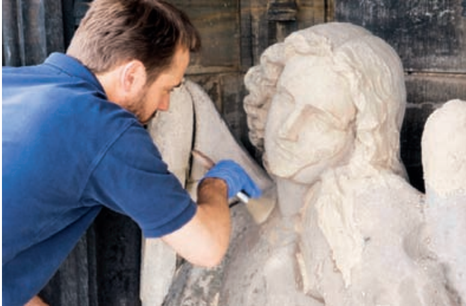
19. Konservatorische Sicherungsmaßnahme an einem der musizierenden Turmengel.
