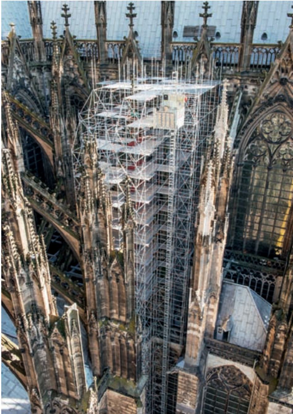
4. Das vollendete Gerüst an Strebenpfeiler A 8–A 9.
