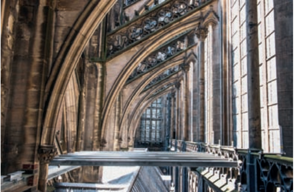
3. Grundgerüst aus Doppel-T-Stahlträgern für die Gerüstplattform über den Feldern 27, 28, 33 und 34.
