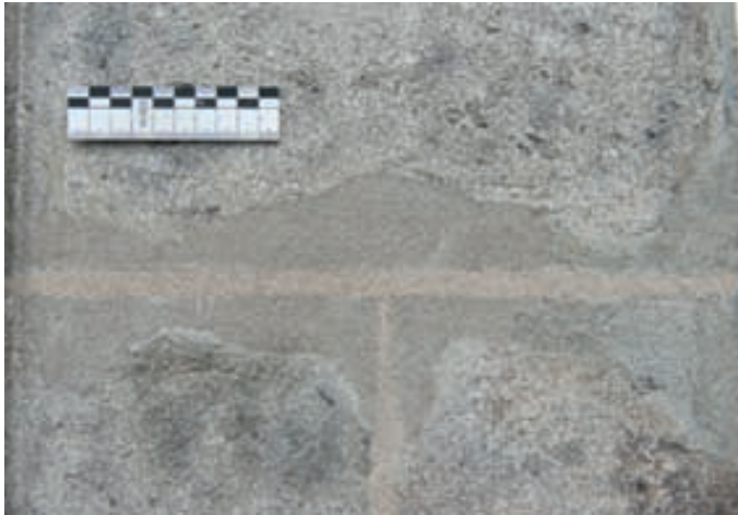
16. Detailansicht von mittelalterlichem Steinwerk und Fugenbild im Bereich des Fensters N III nach der Restaurierung.
