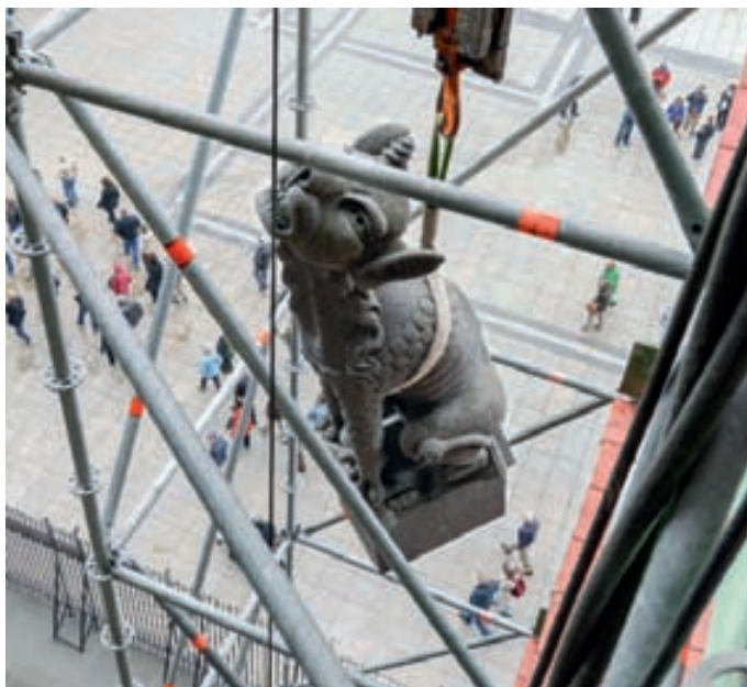
6. Hochziehen des Wasserspeiers für die Westecke von Pfeiler G 8.
